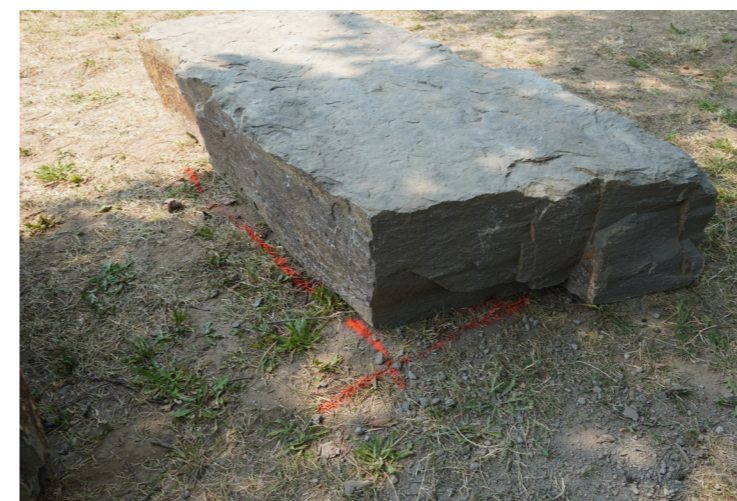
Markierung der Steinplatzierung mit Markierungsspray
